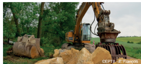
Enrochement d'urgence à Marainville-sur-Madon
