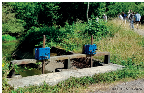
Ouvrage sur l'Ingressin.
