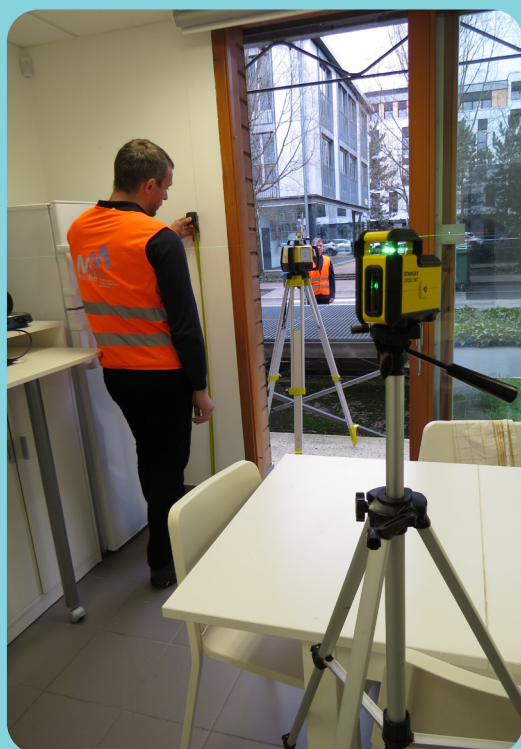
Mesure de hauteur à l'aide d'un niveau © EPTBMM - N. Alosi
