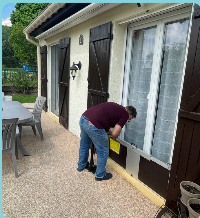
Pose d'un batardeau © EPTBMM - M. Grosjean
