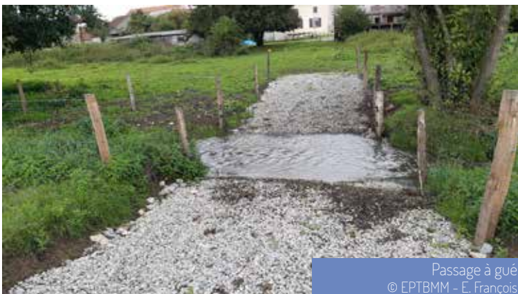
Réserve incendie à Poussay © EPTBMM - E. François
